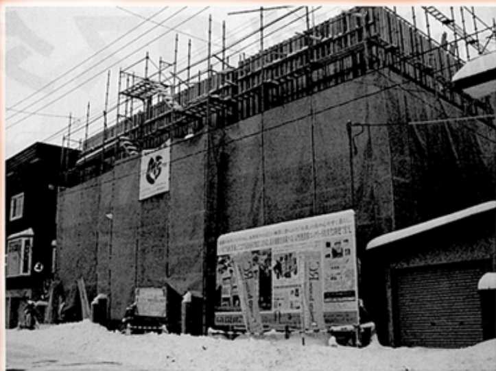
建築中の第1号物件(3棟)
